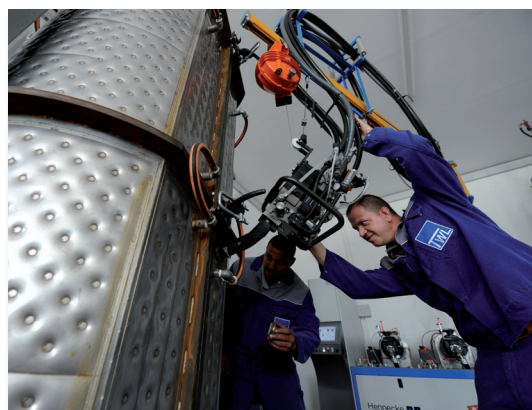
Unsere Mitarbeiter in Aktion beim Aufschäumen der Isolierung
